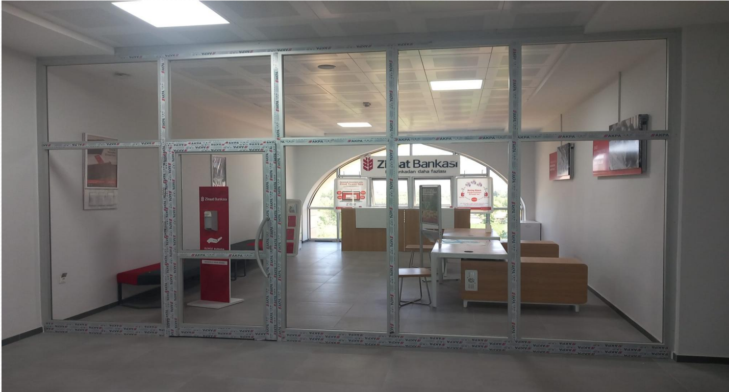
Pazar MYO alüminyum doğrama işleri
